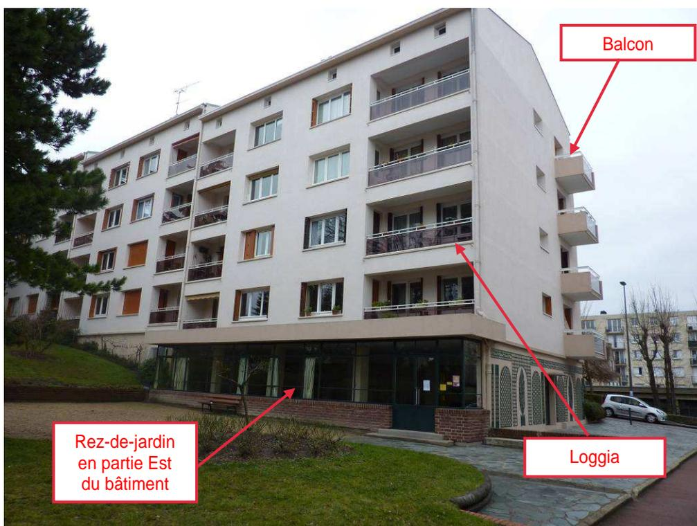
Figure 2 : Caractéristiques des différentes parois
