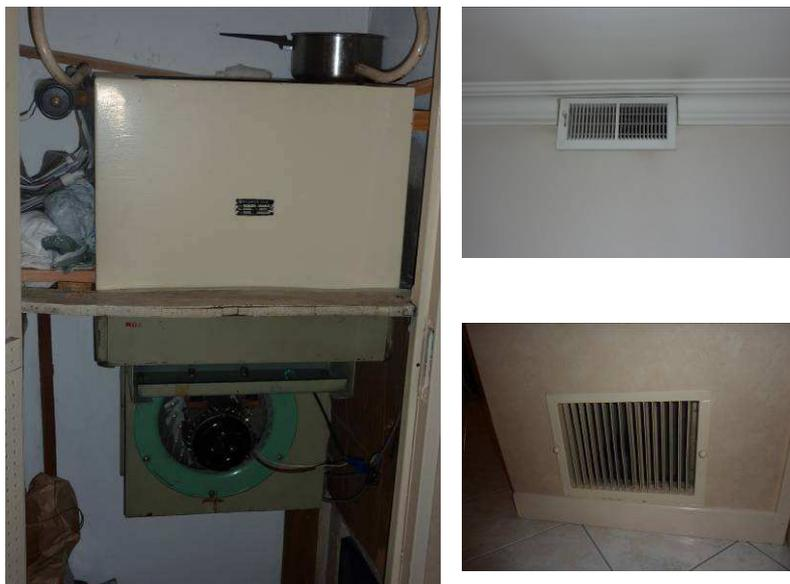
Figure 8 : Aérotherme dans le placard d'entrée et grilles de soufflage et de reprise
