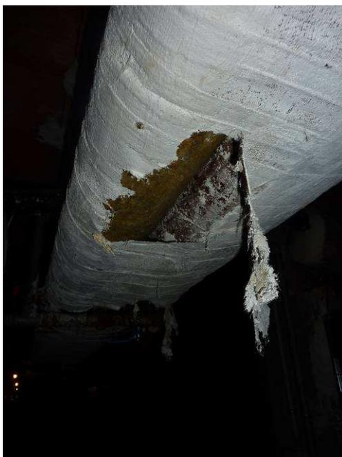
Figure 15 : Calorifugeage dégradé sur les circuits dans les caves
