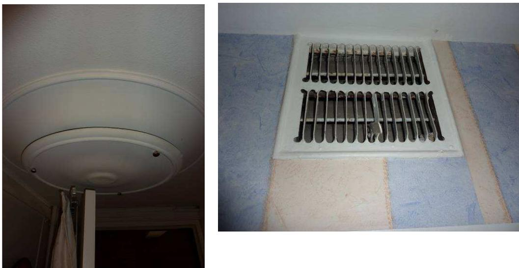
Figure 7 : Aérotherme en faux plafond (dans l'entrée) et grille de soufflage
