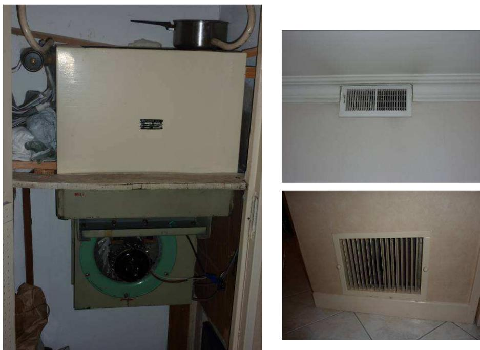
Figure 4 : Aérotherme dans le placard d'entrée et grilles de soufflage et de reprise
